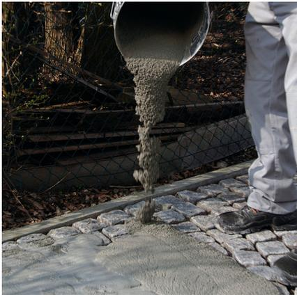
Aufbringen von PCI Pavifix CEM auf die zu verfumende Fläche.
